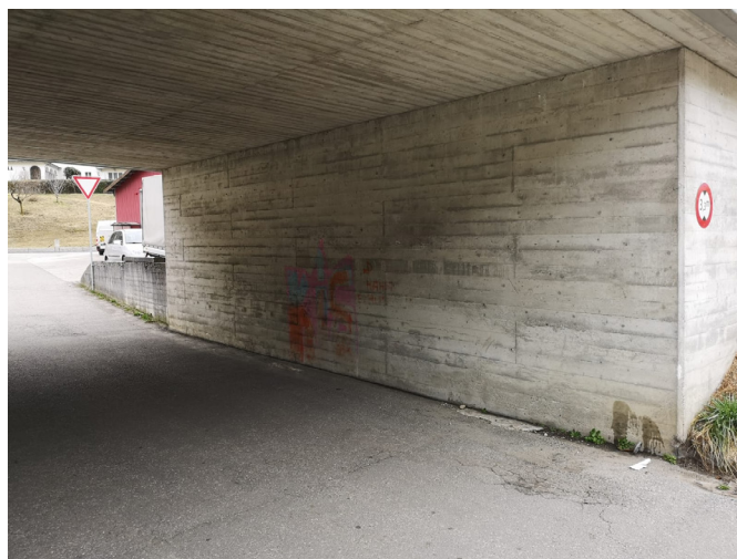
Sottopassaggio vicino al garage Domacar di Malvaglia
